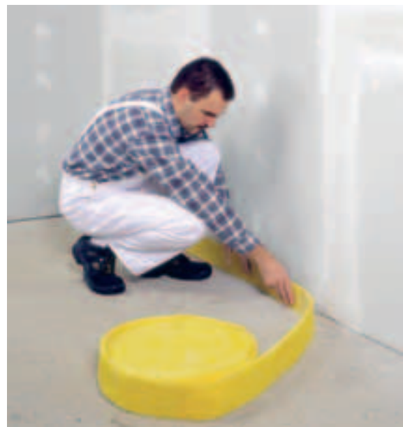
Namestitev robnega izolacijskega traku
