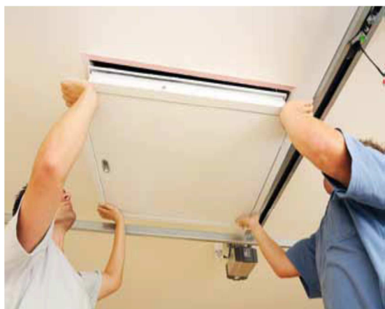
9. V zgornjem prostoru naj tretja oseba vstavi vijak v odprtine nosilcev okvirja
