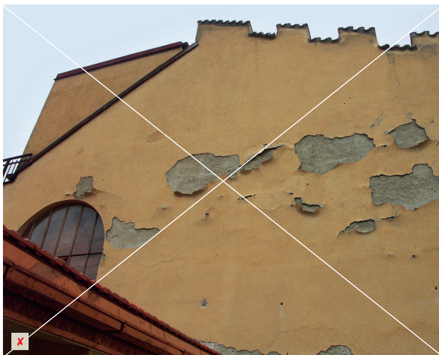
Rezultati renovacij s preveč zatesnitvenimi ali pretogimi izravnalnimi masami
