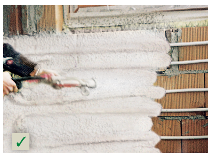
Stensko ogrevanje, vgrajeno v ometu RÖFIX Renoplus®
