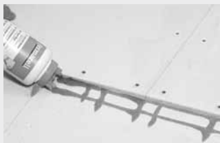
Lepilo na robu plošče 3. sloja proizvodov fermacell
