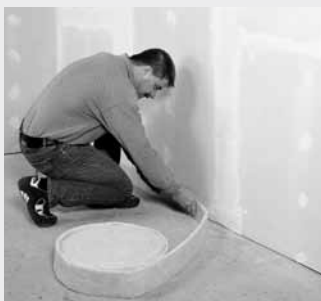
Namestitev robnih izolacijskih trakov
