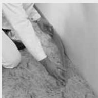
Polaganje robnih izolacijskih trakov, stiki v kotih topo stisnjeni
