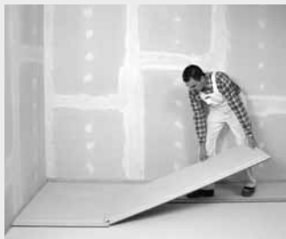
Polaganje estrih elementov fermacell na izravnalno nasutje fermacell
