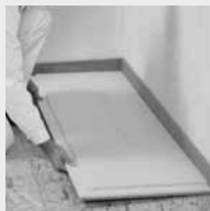
Polaganje estrih elementov fermacell
