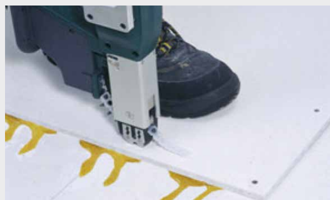
Slika 6: Povezava obeh slojev fermacell z vijaki.
