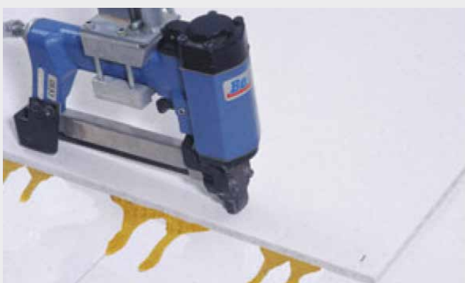
Slika 5: Povezava obeh slojev fermacell s sponkami.
