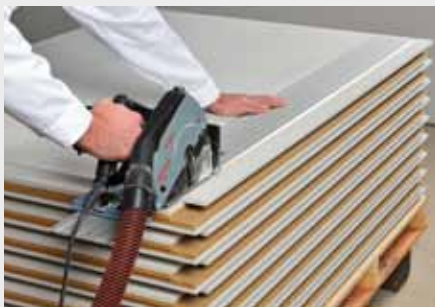
Žaganje odvečnega dela utora za prvo vrsto polaganja
