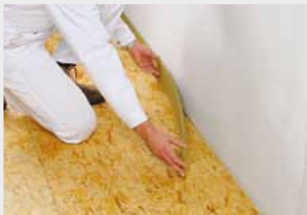
Položite robne izolacijske trakove in jih v vogalih topo stikujte
