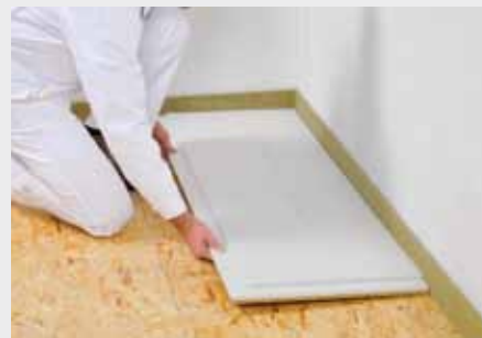
Polaganje estrih elementov fermacell
