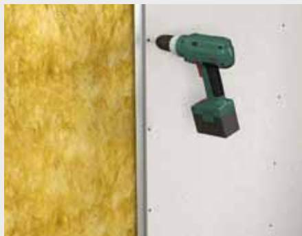
Vijačenje na kovinsko podkonstrukcijo
