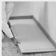
Polaganje estrih elementov fermacell
