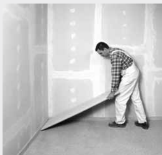
Polaganje estrih elementov fermacell
