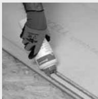
Lepljenje utora z lepilom za estrihe fermacell
