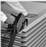
Žaganje odvečnega dela utora za prvo vrsto polaganja
