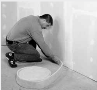
Namestitev robnih izolacijskih trakov
