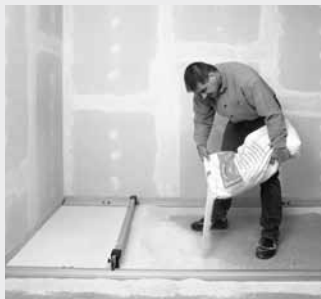
Vgradnja izravnalnega nasutja fermacell
