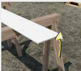
Nanašanje zaščitnega premaza za rezane robove ColourPlus™ Kanten-versiegelung pred vgradnjo plošče.
