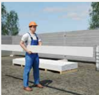
HardiePlank® panele nosimo pri montaži vedno pokončno.
