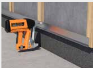
Pritrjevanje podzidnega prezračevalnega profila .
