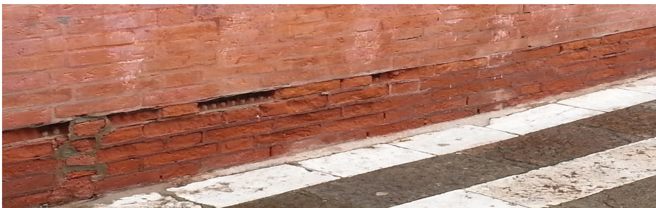
Pregrada v zidu
