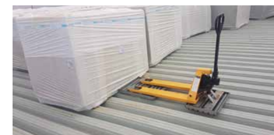
Transportni voziček za palete po strehi
