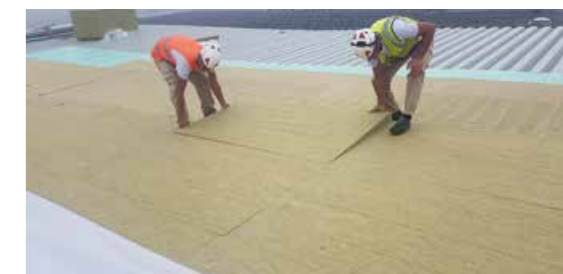
Vgrajevanje strešnih plošč
