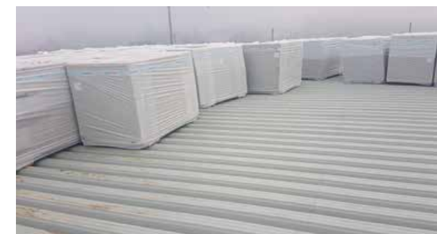
Palete strešnih plošč kamene volne na strehi
