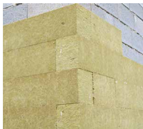
Slika lepljenja fasadne lamele FKL
