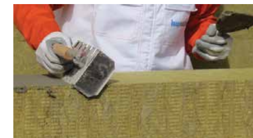
Slika nanosa lepila na fasadni lameli FKL
