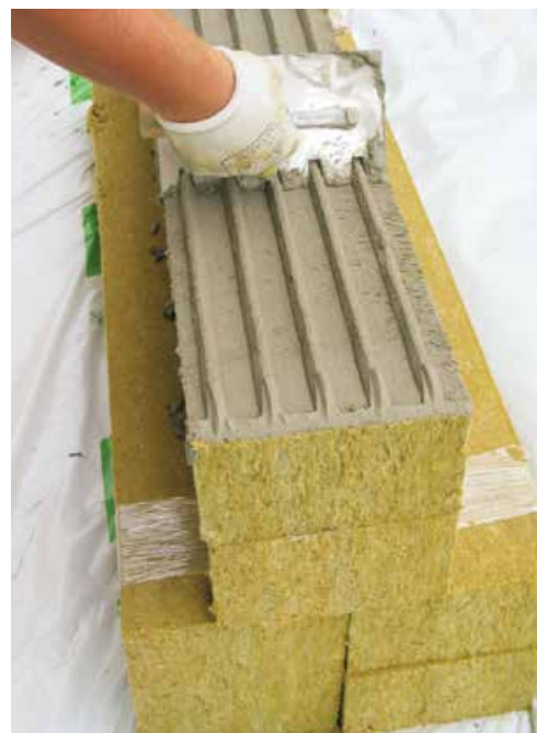
Slika lepljenja fasadne lamele FKL
