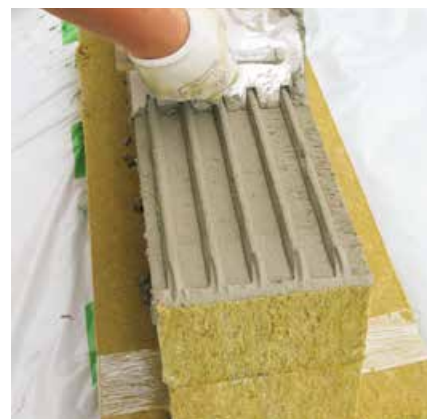
Slika lepljenja fasadne lamele FKL
