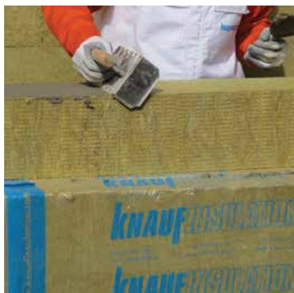
Slika nanosa lepila na fasadni lameli FKL
