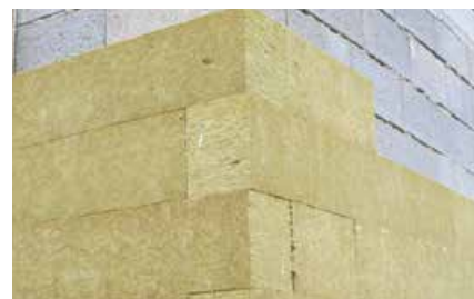
Slika lepljenja fasadne lamele FKL
