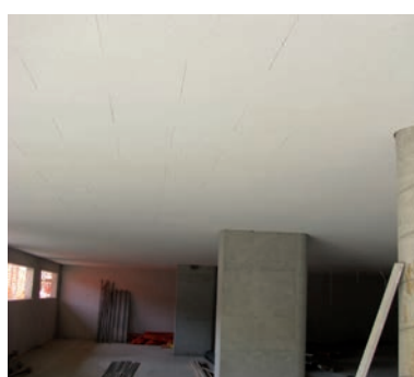
Toplotna zaščita stropa garaže v stanovanjskem bloku v Mariboru
