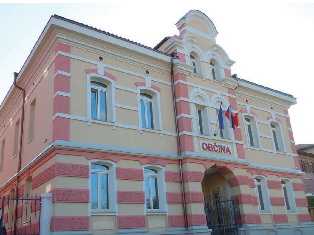
Energetska prenova občine Miren z izvedbo toplotno-izolacijske fasade
