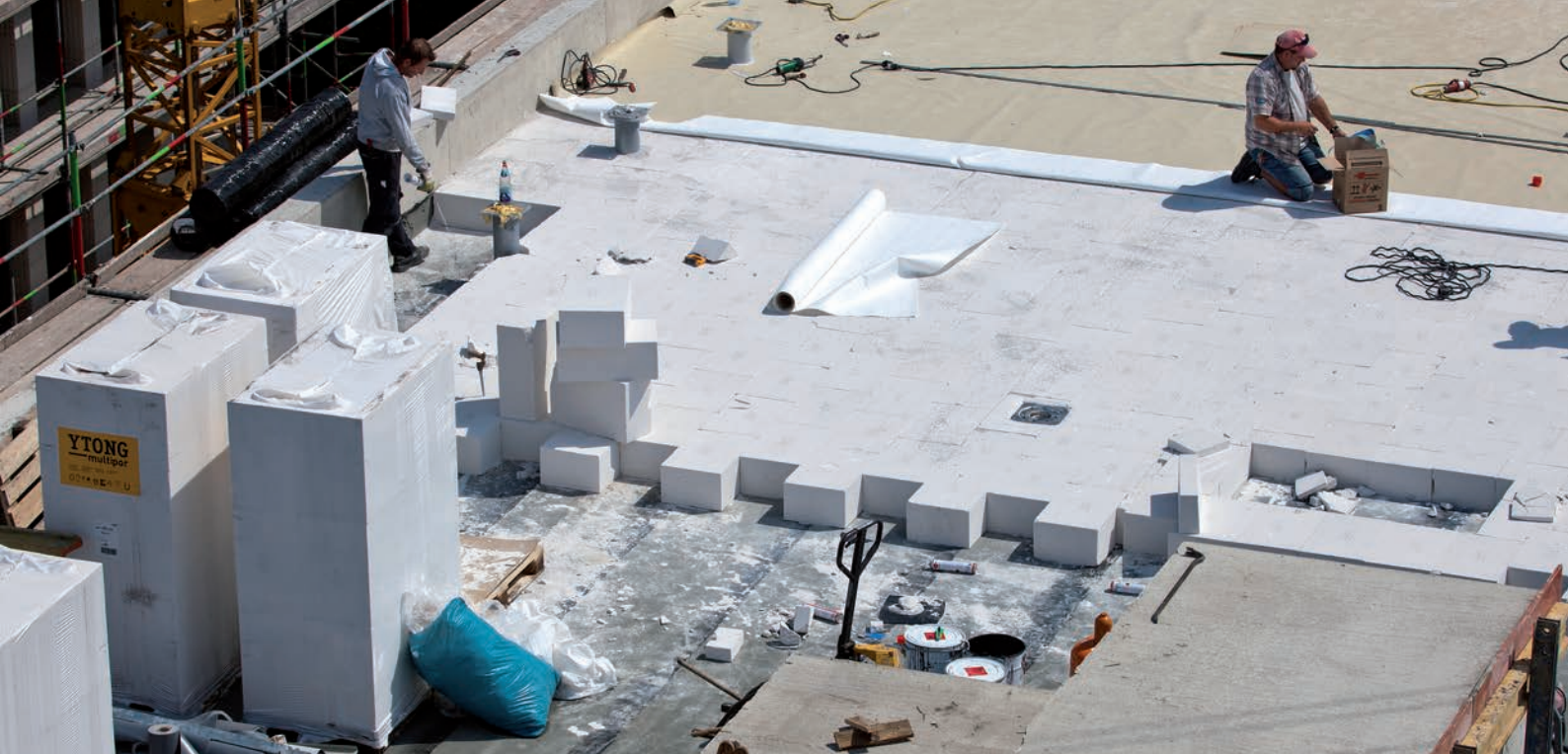
Izvedba izolacije ravne strehe z Multipor ploščami
