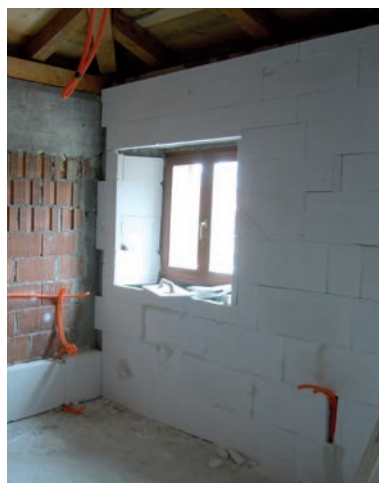
Prenova Gostilne Dragica v Sežani; notranja izolacija
