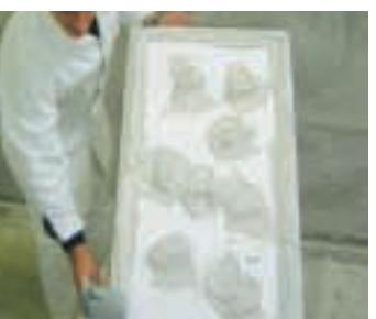
Notranje izolacijske plošče RÖFIX Renopor I lahko zlepimo s specialno lepljivo-izravnalno maso v debelini 1 do 3 mm. Pri sanacijskih ploščah RÖFIX Renopor S nikoli ne lepimo fug, temveč plošče polagamo tesno drugo ob drugo na čisti stik. Za pritrjevanje plošč ne uporabljamo pritrtilnih sider zaradi morebitnega topotnega mostu. Plošče lahko prevlečemo z armirno maso že po dveh urah.
