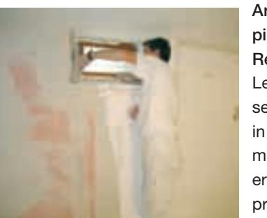
Armiranje plošč s specialno lepljivo-izravnalno maso RÖFIX Renopor Spezial-Klebespachtel
