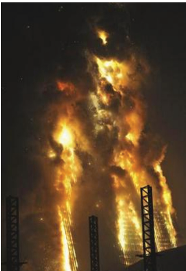
Sliki B.1: Najbolj znan primer požara med izvedbo toplotne zaščite stavbe z gorljivo izolacijo, ki še ni bila prekrita z zaključnim slojem, v stolpu CCTV v Pekingu (China Central Television headquarters) (Vir: http://online.wsj.com , http://www.reuters.com )
