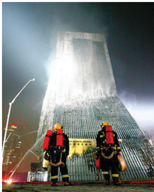
Sliki B.1: Najbolj znan primer požara med izvedbo toplotne zaščite stavbe z gorljivo izolacijo, ki še ni bila prekrita z zaključnim slojem, v stolpu CCTV v Pekingu (China Central Television headquarters) (Vir: http://online.wsj.com , http://www.reuters.com )
