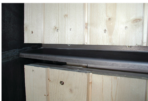
Risba 3: Primer zaščite, ki določen čas preprečuje vertikalni prenos požara po leseni fasadi (Vir: FASSADEN AUS HOLZ, GVZ)
