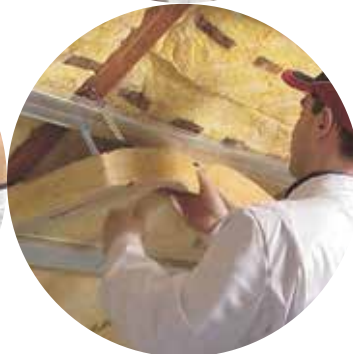
Slika 6: Pod kovinski C-profil vstavimo drugi sloj izolacije
