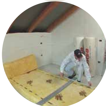
Slika 4: Izolacijo razrežemo na primerno velike plošče
