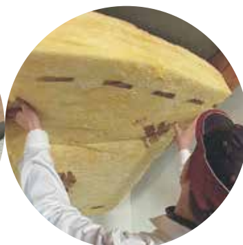
Slika 5: Izolacijo vstavimo med špirovce
