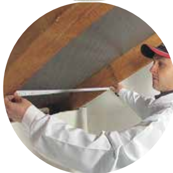
Slika 2: Predhodno položena paroprepustna folija – sekundarna kritina
