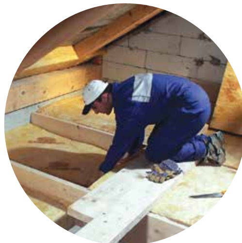
1. Polaganje prvega sloja izolacije med lesene distančnike
