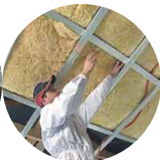
2. Postavimo prvi sloj izolacije
