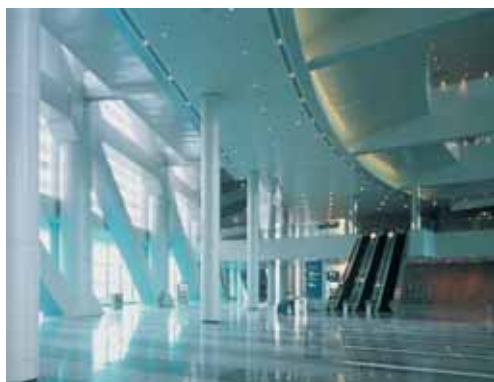
Pri izgradnji letališča v Hong Kongu so bili uporabljeni sistemi FERMACELL
