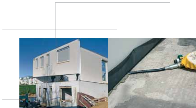
Predhodno montirani stenski element s FERMACELL-om
